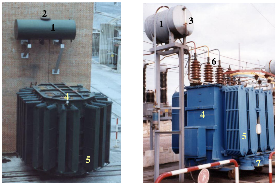
Fig. 5: Transformadores en baño de aceite a) 1: Depósito de expansión; 2: Tapón de llenado b) 3: Nivel de aceite 4: Cuba del transformador 5: Radiadores 6: Pasatapas de A.T. 7: Ventiladores para enviar aire hacia los radiadores
