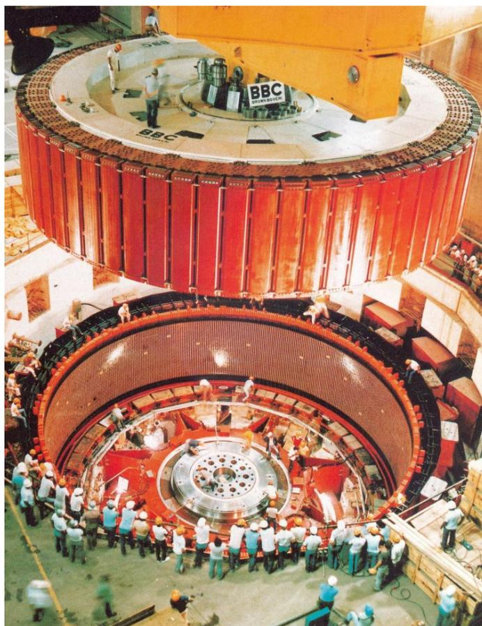
*Fig. 33: Hidroalternador síncrono trifásico de la central de Itaipú de 824 MVA, 90 r.p.m., 60 Hz (Fuente: Revista ABB, n° 1, 1992).*
