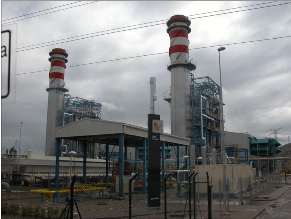
Central Térmica de Ciclo Combinado (I) Arrubal, La Rioja (2 x 400 MW)
