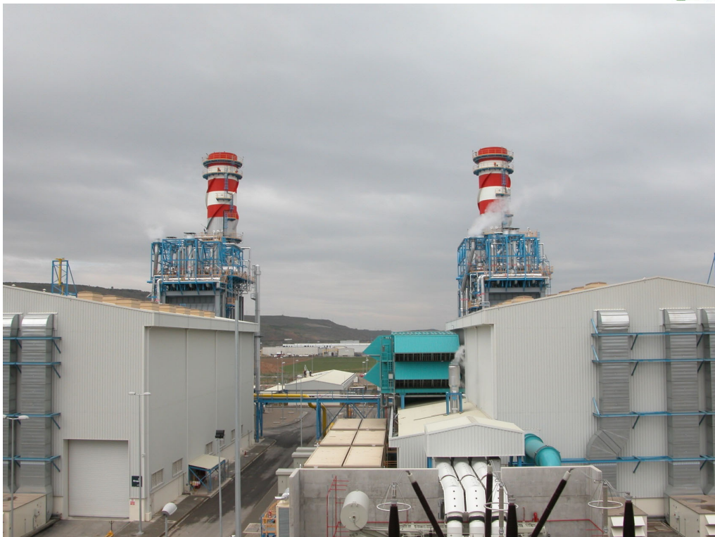
Central Térmica de Ciclo Combinado (II) Arrubal, La Rioja (2 x 400 MW)
