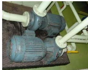
Bombas centrífugas
