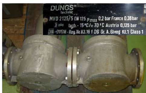
Rampa de Gas: Electroválvulas
