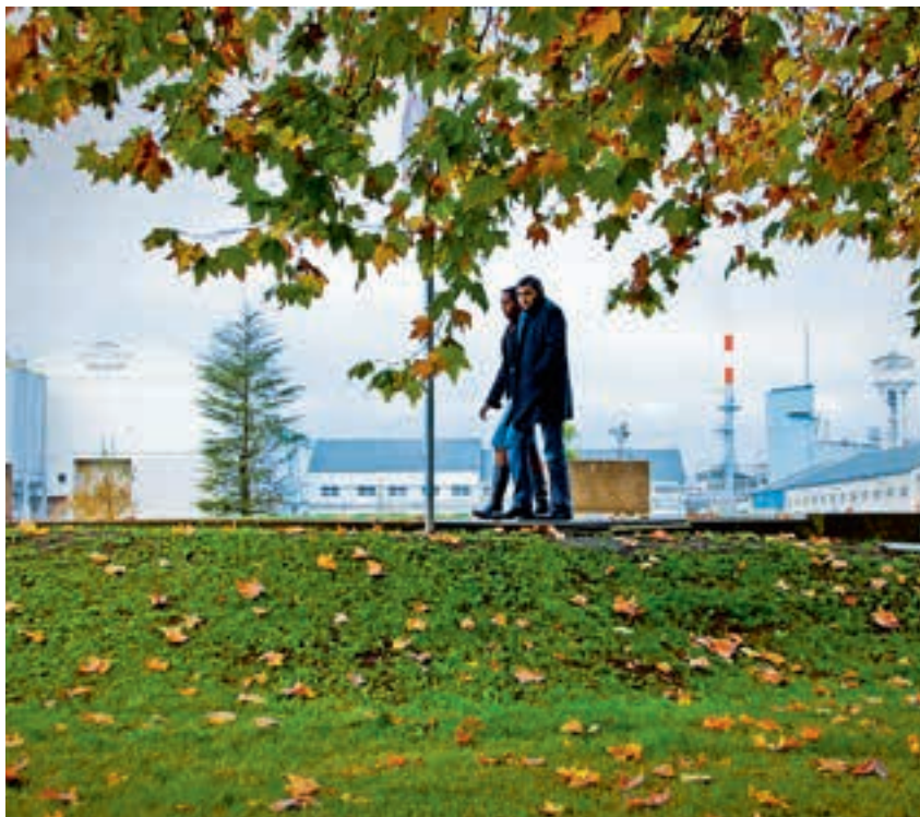
Centre de Recherche Isolation de Rantigny (France)
