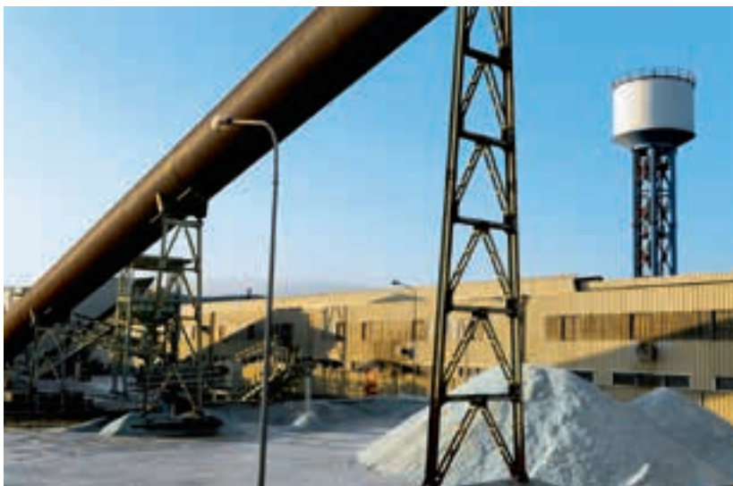
Stockage du calcin, site d'Eurofloat (France)
